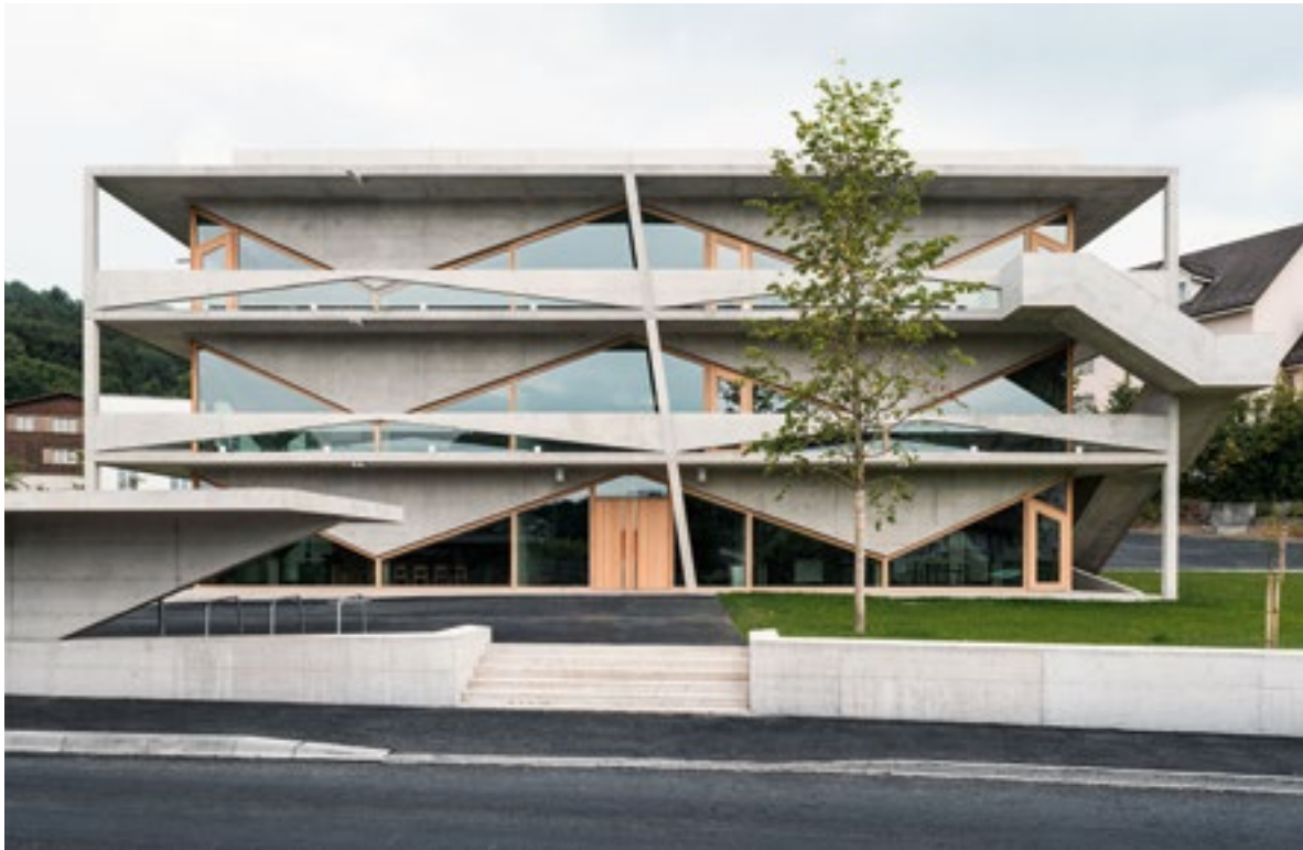
Die Fassade ist expressiv, ohne formalistisch zu sein: Der gezielte Materialeinsatz und die Gegensätze massiv–filigran ergeben sich aus den Kraftflüssen. Sämtliche Bauteile der äussersten Schicht des Gebäudes sind tragend ausgebildet.
